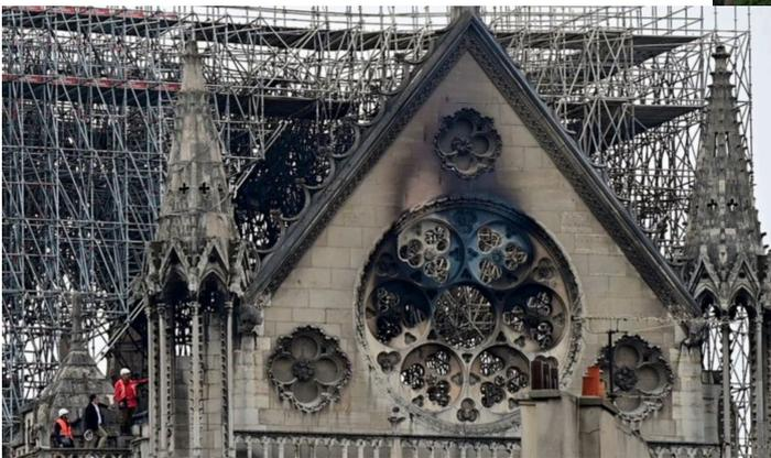
がかけられ、聖堂内に新たな足場が組まれた。鉛の屋根が燃えた際に拡散した粉塵が引き起こす鉛中毒対策は、今も工事に大きなブレーキをかけている。大規模で危険を伴う修復工事だが、屋根を支える木組みの檜の木が伐採され始めた。入念に選別された樹齢200-300年の原木を切り出し、これから1-2年乾燥させて、鉛の屋根を支える
