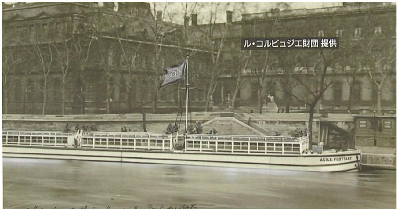
「船はセーヌ川床に着いている。セーヌ川は大海の海ではない。船底が均一に川床に着いていないので、全長70mのコンクリート船は傾いてねじれている。しかし、船内に溜まった2000m<sup>3</sup>の水をゆっくりポンプアップすれば、船底に大きな破損がない限り、ゆっくりと自力で元に戻ろうとする。外圧は逆効果で、ポンプアップで船は自然に浮かび上がる。」
